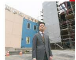
▲4階建ての防災施設。実際には4階建てぐらいの高さになるそう。また、150tの貯水槽も完備している
