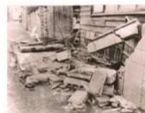
倒れたブロック塀
